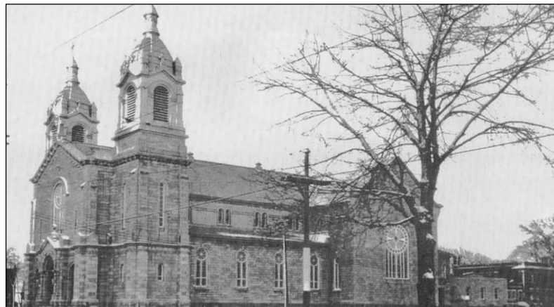
1914-1964 (démolie pour la construction du pont-tunnel LHL)
